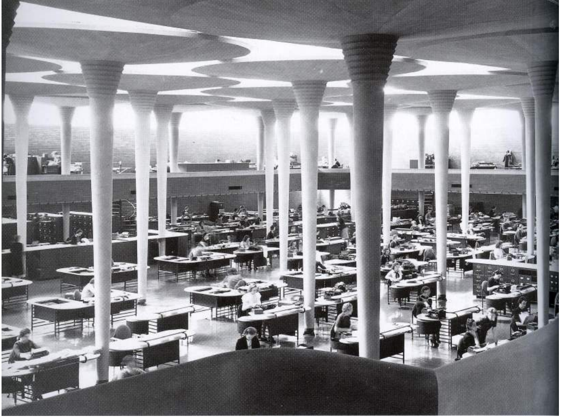
Şekil 2.17 F.L. Wright'ın strüktürel analogisi: S.C Johnson Wax Company binası mantar biçimli taşıyıcı sistemin iç mekan görünüşü. (Taschen, 1994, s:144)
